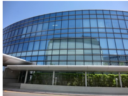
北海道エアポート（株）様 本社の入っているビル
